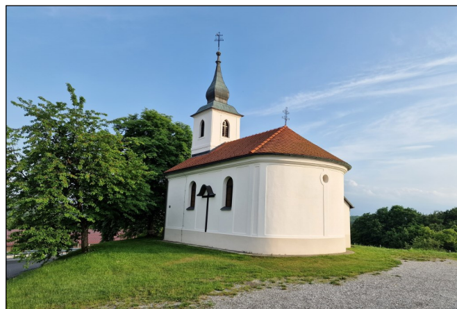
Neue Fassade und sanierte Sakristei der Vitus Kapelle Welten-Deutscheck
