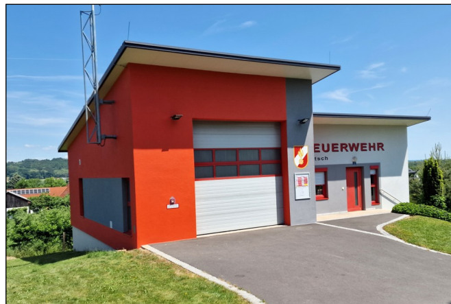
Neue Fassade Feuerwehrhaus Gritsch
