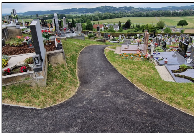
Teilsanierung der Friedhofswege
