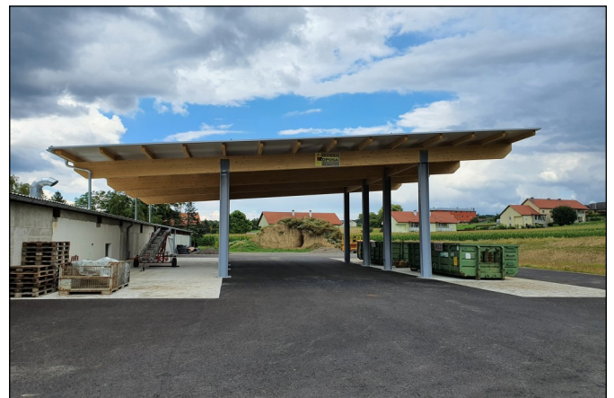
Bauhofzubau mit überdachter Abfallsammelstelle
